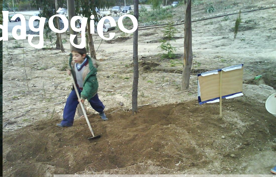
Terraplanagem do terreno
