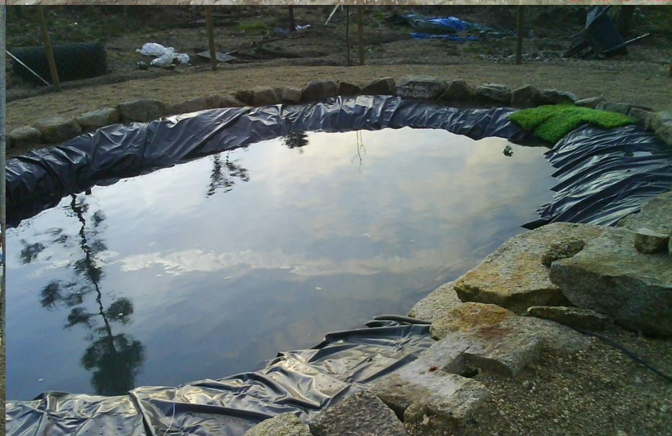
Finalização da construção
