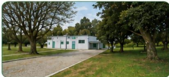
Estação de Tratamento de Água dos Ribeiros
